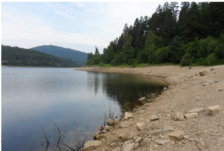
Schwarzenbachtalsperre (BW) © Eberhard Hoehn
